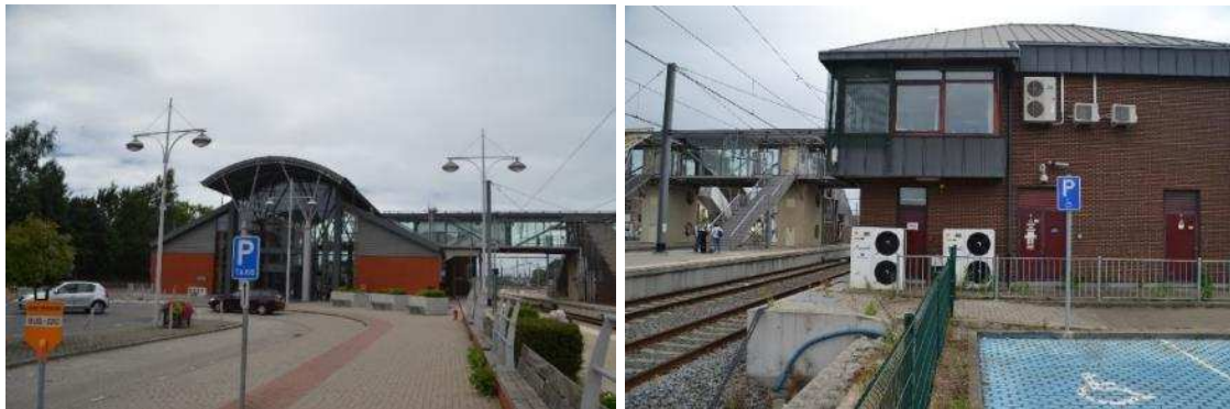
Figure 64 : Gare de Gembloux, avenue de la Station (ARIES, 2017)
