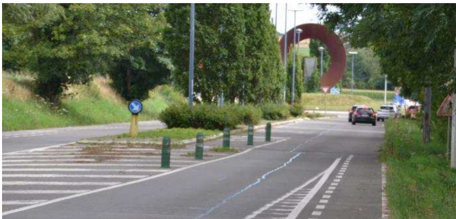
Figure 173 : Vue sur l'absence d'infrastructures piétonnes au droit de la chaussée de Namur (N4) entre le rond-point des 3 clés et le carrefour avec la chaussée de Wavre (ARIES, 2017)
