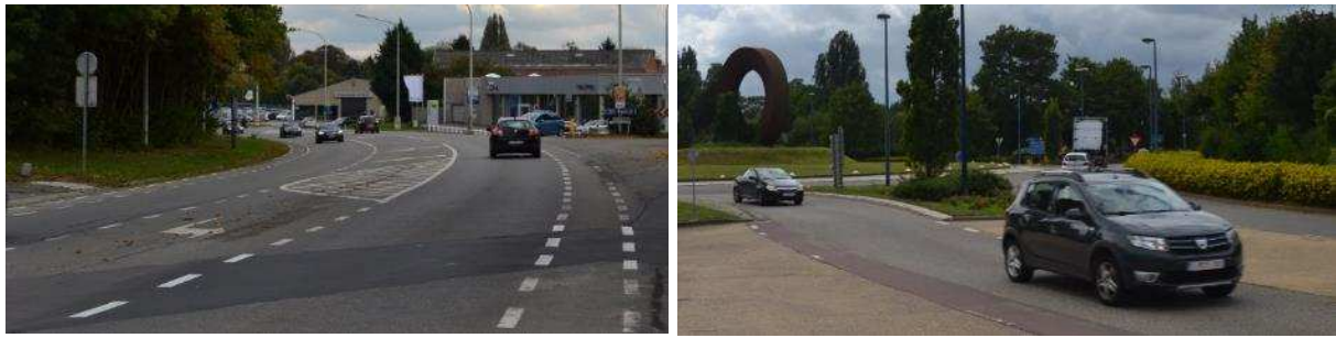
Figure 167 : Vue sur les pistes cyclables de la chaussée de Namur (N4) à hauteur du carrefour avec la chaussée de Wavre (à gauche) et sur les pistes cyclables de la chaussée de Tirlemont (N29) à hauteur du rond-point des 3 clés en direction de l'E411 (à droite) (ARIES, 2017)
