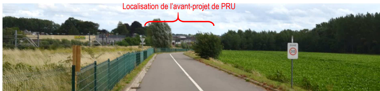
Figure 95 : Vue depuis l'entrée du parking SNCB (ARIES, 2017)
