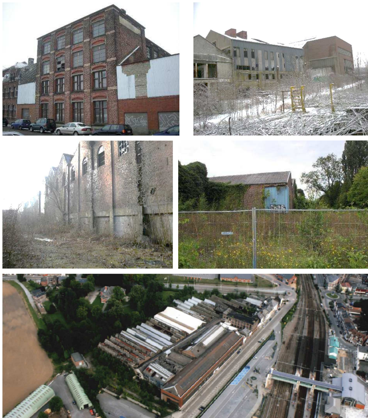
Figure 59 : Situation avant démolition (ARIES, EUROGEMBOUX, 2009)
