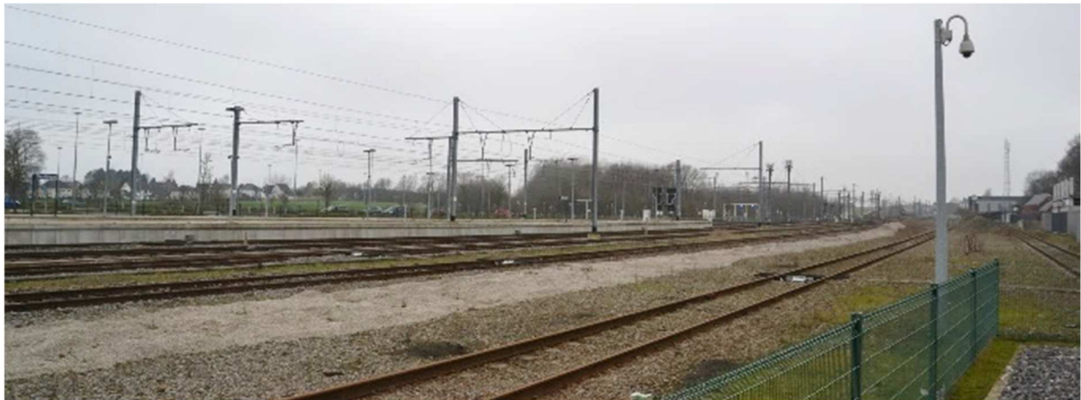
Figure 81 : Vue vers la voie de chemin de fer (ARIES, 2017)
