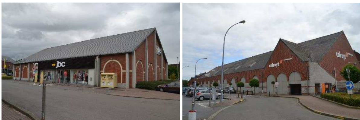
Figure 61 : Rue de la Sucrerie (ARIES, 2017)
