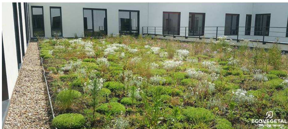
Figure 214 : Vue sur une toiture végétale extensive de sédum (ECOVEGETAL)
